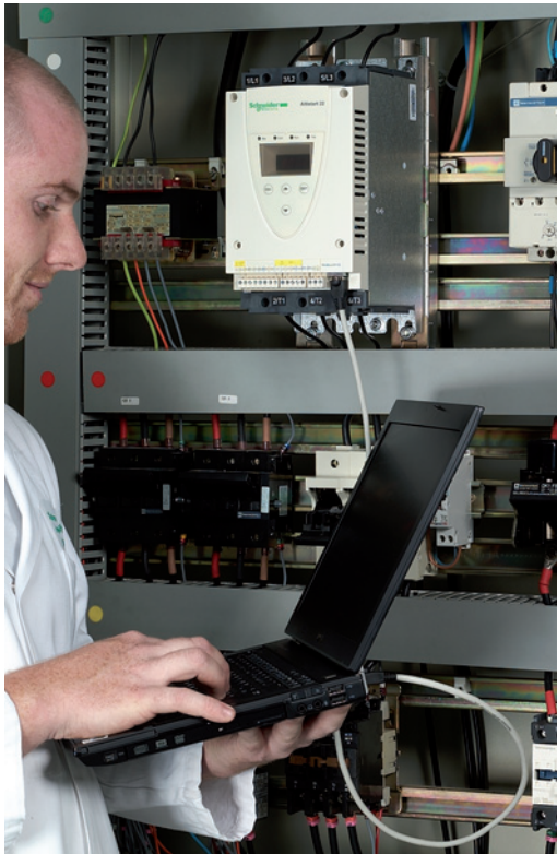
Тестування і пуск пристрою плавного пуску/зупинки ATS22 за допомогою програмного забезпечення SoMove
